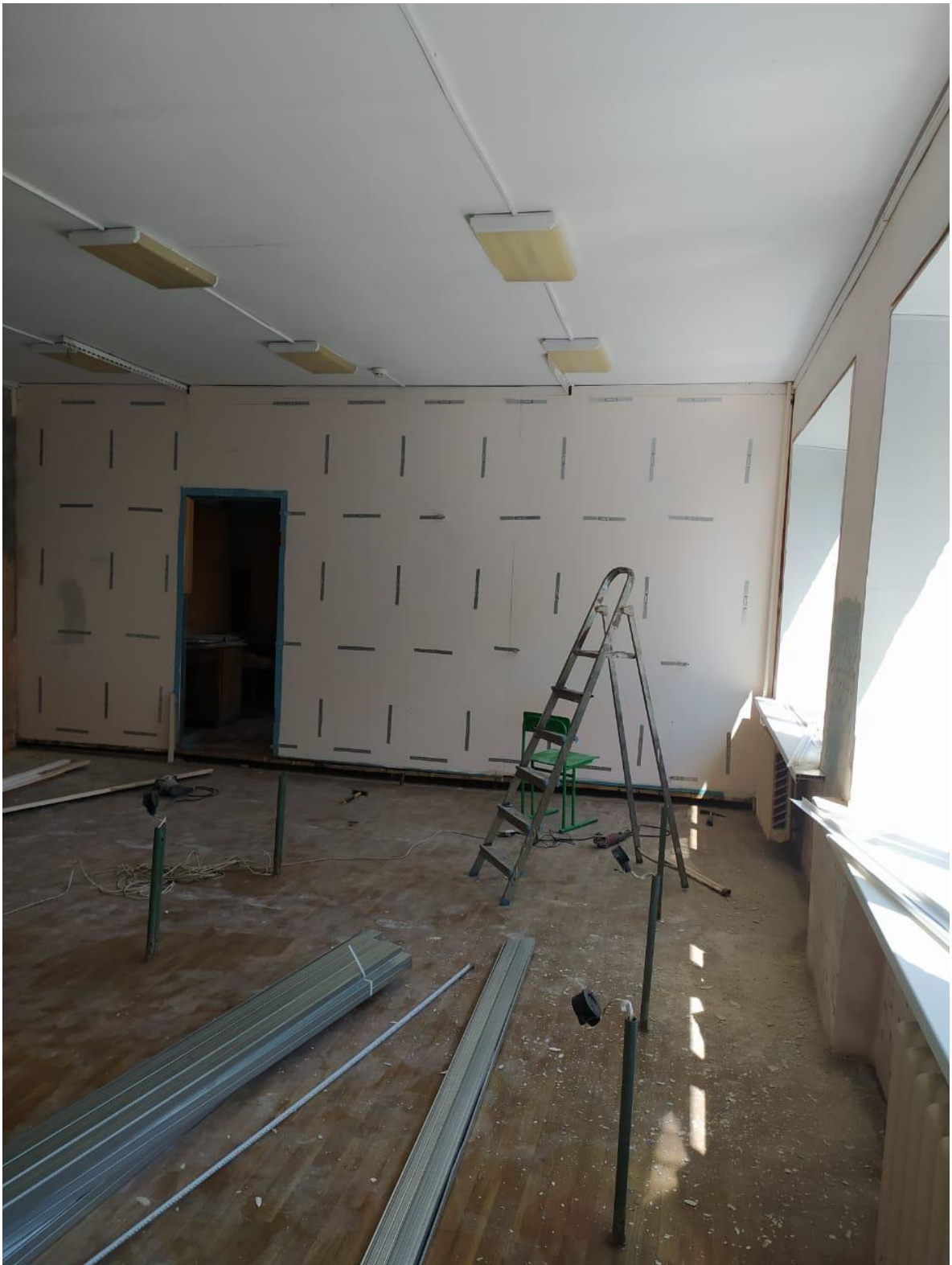
Кабинет физики после ремонта
